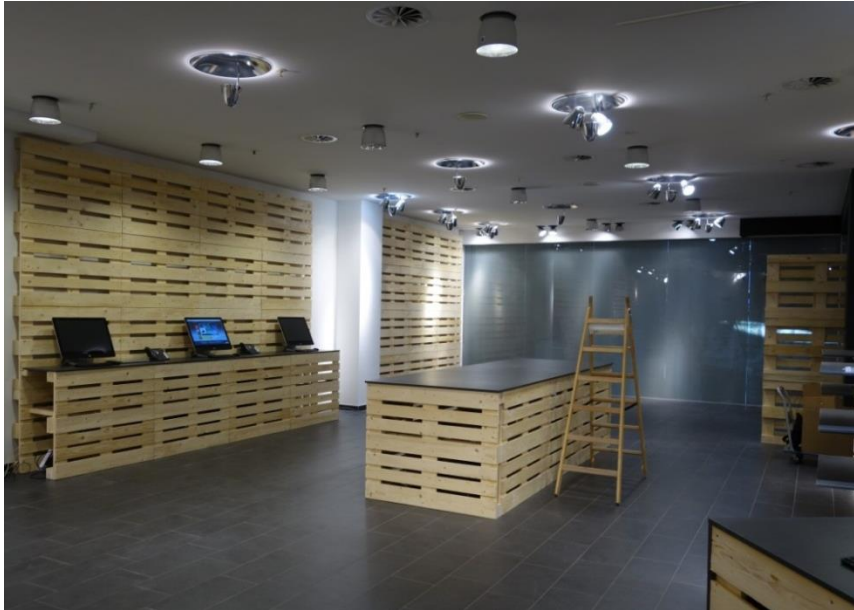
Die Eröffnung steht kurz bevor: Bauarbeiten am Pop-up-Store anfangs November
